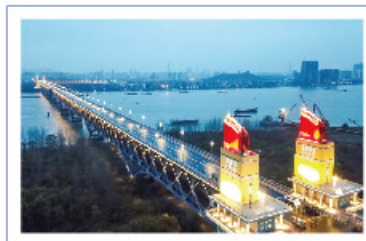
南京长江大桥修复工程
